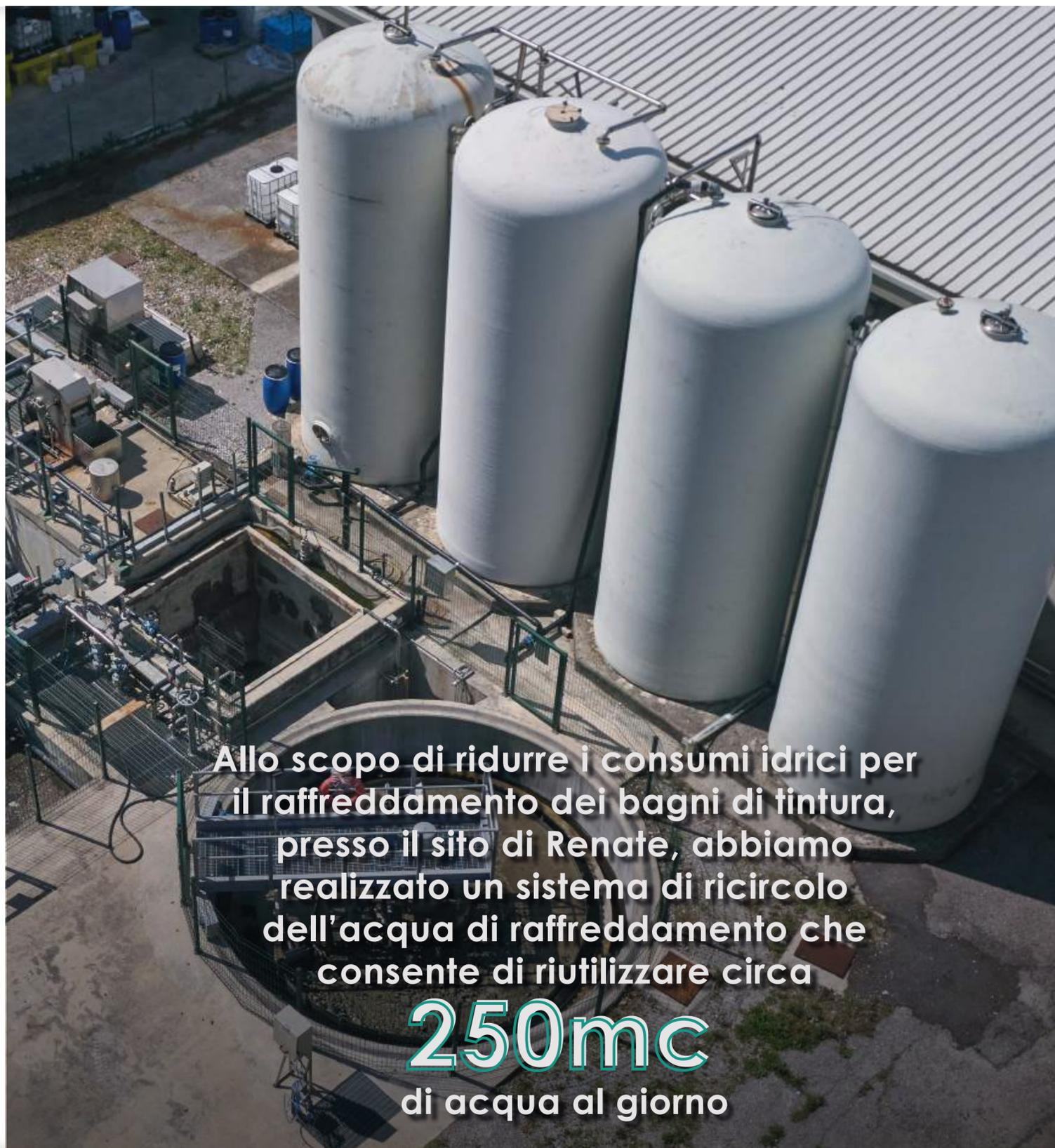
Allo scopo di ridurre i consumi idrici per il raffreddamento dei bagni di tintura, presso il sito di Renate, abbiamo realizzato un sistema di ricircolo dell'acqua di raffreddamento che consente di riutilizzare circa **250mc** di acqua al giorno
